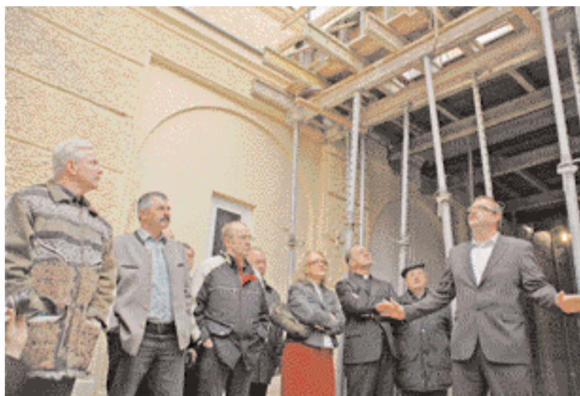
Baustellenbesichtigung mit Bauleiter Wolfgang Wenger. (Foto: Jockenhöfer)
