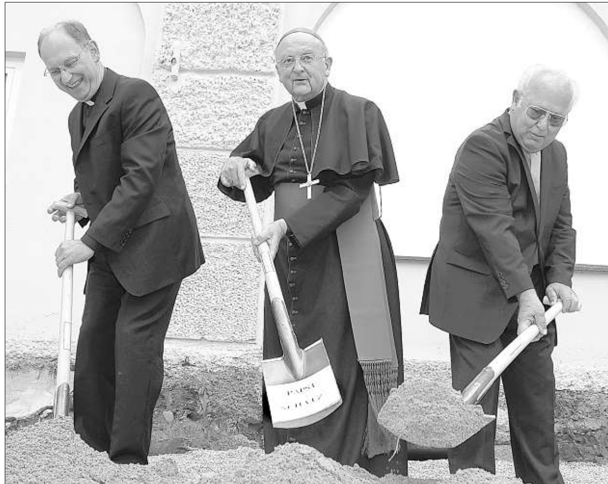
Spatenstich für die neue Schatzkammer mit Bischof Wilhelm Schraml, Administrator Alois Furtner (rechts) und dessen Nachfolger Ludwig Limbrunner (links). – Foto: Willmerdinger
