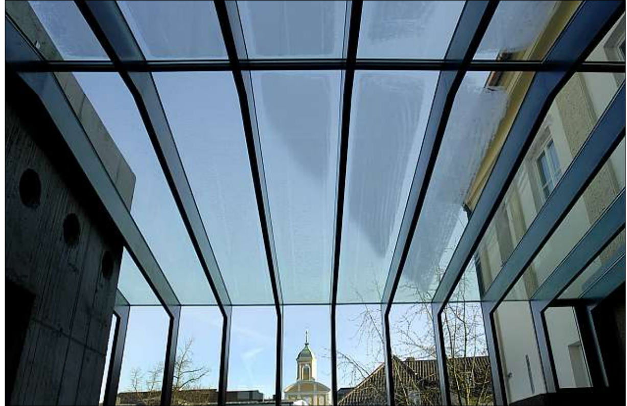
Transparent und lichtdurchflutet gestaltet sich der Übergangsbereich zwischen dem Neubau der Schatzkammer und dem Altbau der Administration. Für die Abwicklung dieser Maßnahme ist Wolfgang Hesel zuständig.
